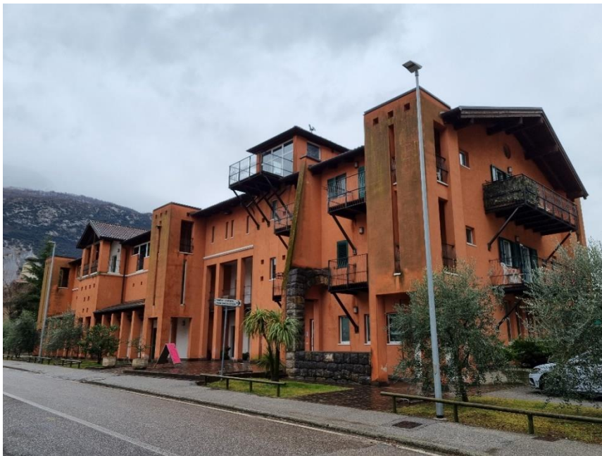
Immagine 5. Vista edificio – fronte nord-est
